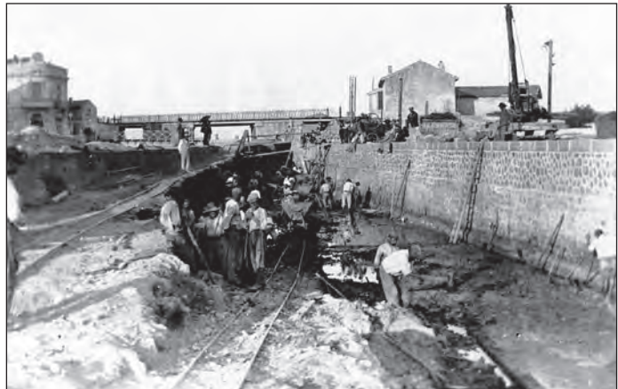
L'élargissement du canal
