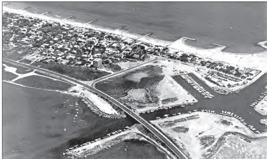
Le port de plaisance en construction
