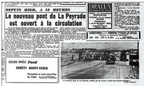
La presse locale annonce l'ouverture du nouveau pont de La Peyrade. [Midi Libre du 11 mars 1954].
