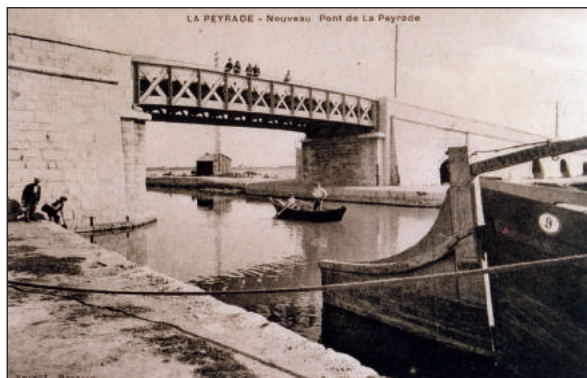
Pont métallique de La Peyrade édifié au-dessus du canal du Rhône à Sète en 1925. L'ossature est en forme de croix de Saint-André. [Collection Archives municipales de Frontignan la Peyrade].
